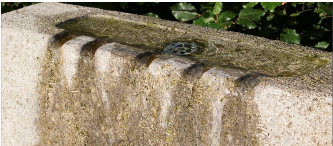
Die Überlaufrinne zur Wasserverteilung
